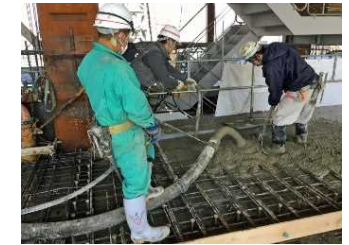
Вьетнам эрэгтэй (29 настай) [Шахуургын помпоор бетоныг хэвд нь хийж буй нь]
