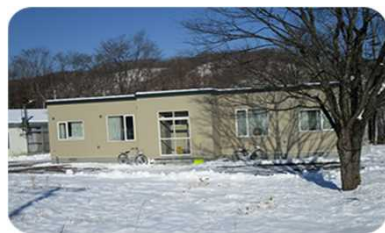
Дадлагажигчийн дотуур байр. Хувийн өрөөтэй бөгөөд гал тогоо, 14.592 м 2 нийтийн өрөө, унтлагын өрөө, банны өрөө, ариун цэврийн өрөөтэй
