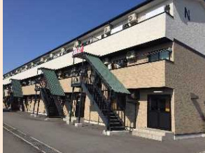
Шинээр ашиглалтанд орсон гадаад ажилтны тусгай дотуур байртай (Гаднаас харагдах байдал)
